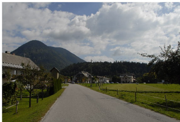
10 pogled na cesto, ki se prestavlja ter novo traso po travniku
