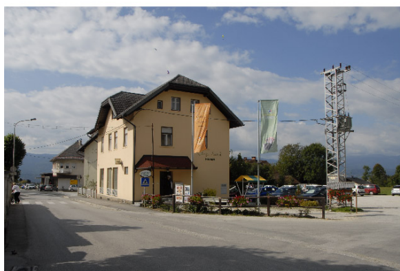
5 pogled na objekt "galerija Avsenik"
